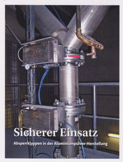
Ein Hersteller von Metallpulvern setzt unterhalb eines Zyklons, der zur Alumiumpulver-Abscheidung dient, Absperrklappen ein. Diese schleusen das Aluminiumpulver aus dem Verdüsungsprozess aus. Da Aluminiumpulver in Form einer Staubwolke explosiv sein kann, mussten die Absperrklappen den Atex-Richtlinien entsprechen.
